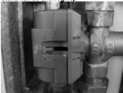
Aanzuiging van regenwater in het opvangreservoir EP
