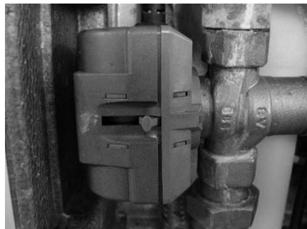
Aanzuiging van leidingwater via de terugstroombeveiliging
